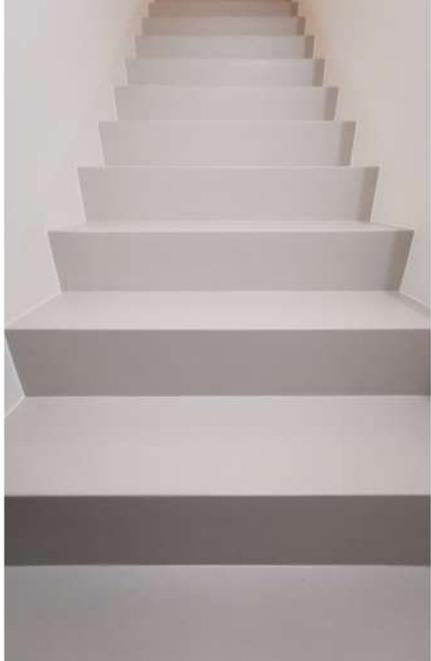
Infine, la scala, un elemento cruciale di ogni casa, è stata rigenerata con l'applicazione di resina in texture Materia. L'uso di Oleomalta® ha permesso di dare vita ad un rivestimento che, oltre a essere esteticamente gradevole, è anche resistente e durevole.
